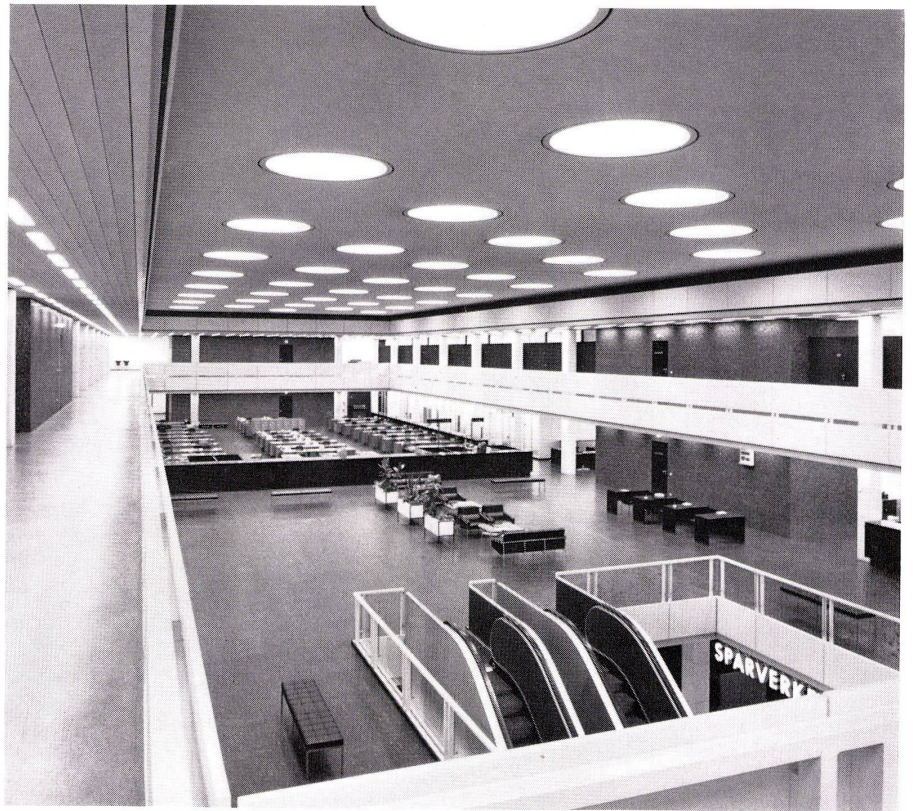
Einblick in die Kassenhalle vom Galeriegeschoß. Vue vers le grand hall du premier étage depuis la galerie. View into hall from gallery level.
