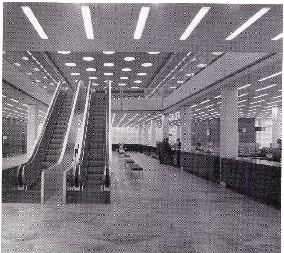
3 Schalterhalle im Erdgeschoß. Fußboden Naturstein (portugiesischer Trigaxes), Tresen: Makassar-Holz, Platte Labrador Granit (dunkelgrün), Wände weißer Schleifack, Stützenverkleidung Kristallino-Marmor, Decke: Ziehringer Streifendecke als Akustikdecke.
