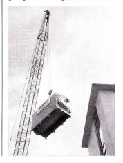
zentralen in Kellergeschossen, bei denen die Einbringung von Kesseleinheiten solch großer Heizleistung oft eine erhebliche Zeit in Anspruch nimmt, wickelte sich der Transport auf das Dach in weniger als 1 Stunde ab.
