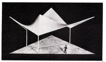
Sodann wird zuerst der «webende» Kunststoff gespritzt, der sich in Form vieler dünner Fäden als dünnes Gespinst über die offenen Zwischenräume des Rasters spannt (Bild 1). Anschließend wird auf diesen Untergrund die hautartige Kokonschicht gespritzt. Diese Schicht kann beliebig dick aufgebaut werden. Schon mit einer Schichtdicke von 0,8 mm erreicht man eine sehr widerstandsfähige, elastische Haut.
