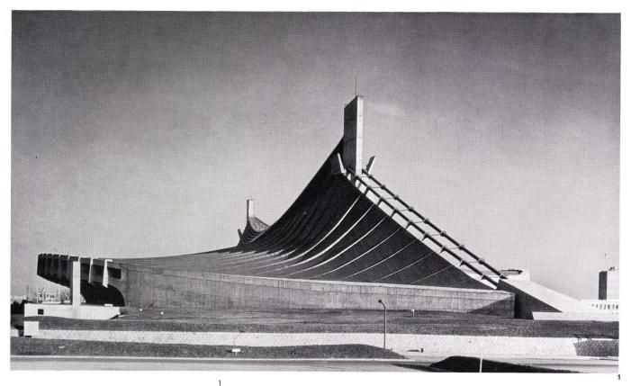
1 Kleine Sporthalle. Blick zum Pylon. Am Pylon sind die Abstandshalter zu erkennen, die das gebogene Rohr aussteifen.
