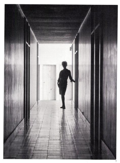
innen überall holzverkleidet, die Badezimmer versehen mit Plastikbelag. Als Deckenmaterial wurde in den Zimmern eine Holzfaserplatte, Typ Heraklith, in allen Korridoren und den allgemeinen Räumen Schilfmatten verwendet, die lichtdurchlässig geflochten wurden und die über diesen Matten installierte Beleuchtung durchscheinen lassen.
