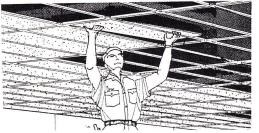
Schnelle und trockene Montage der vorgefertigten und vorgestrichenen Deckenelemente.
