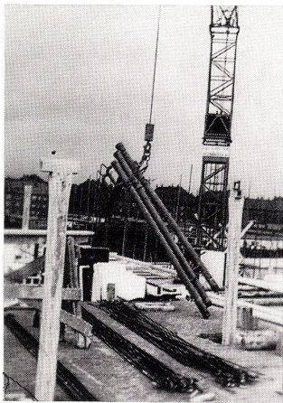
6 Fertigung großer Wandelemente im fliegenden Betrieb.
