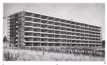
Nach der Herstellung von Dutzenden von vorfabrizierten Elementen, die jeden Tag versetzt werden, erscheint die Struktur des Gebäudes.
