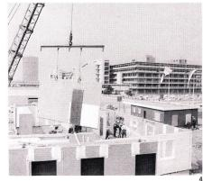
Montage der ersten Außenwände. Das zuletzt eingeschwenkte Element hat eine Länge von 8,75 m und hängt an den gleichen Karabinerhaken, die auch für die Halterung über dem Rollenfließband in der Fabrik verwendet werden. Alle Außenwandelemente sind bis zum Einbau der Zwischenwände mit Plastikfolien gegen Beschädigungen und Witterungseinflüsse geschützt. VW-Busse dienen als Mannschaftswagen und rollendes Magazin für Handwerkszeug.
