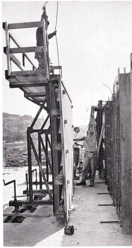
2 Nach eingebauter Armierung wird die Schalung geschlossen. Fermeture du coffrage après la pose de l'armature. The coffering is sealed after reinforcement is built in.
