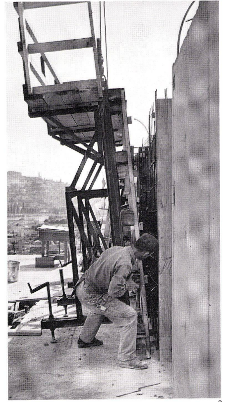
3 Einfügen des 2. Wandschalungselementes. Pose du 2ème élément de coffrage du mur. Positioning of the 2nd wall coffering element.
