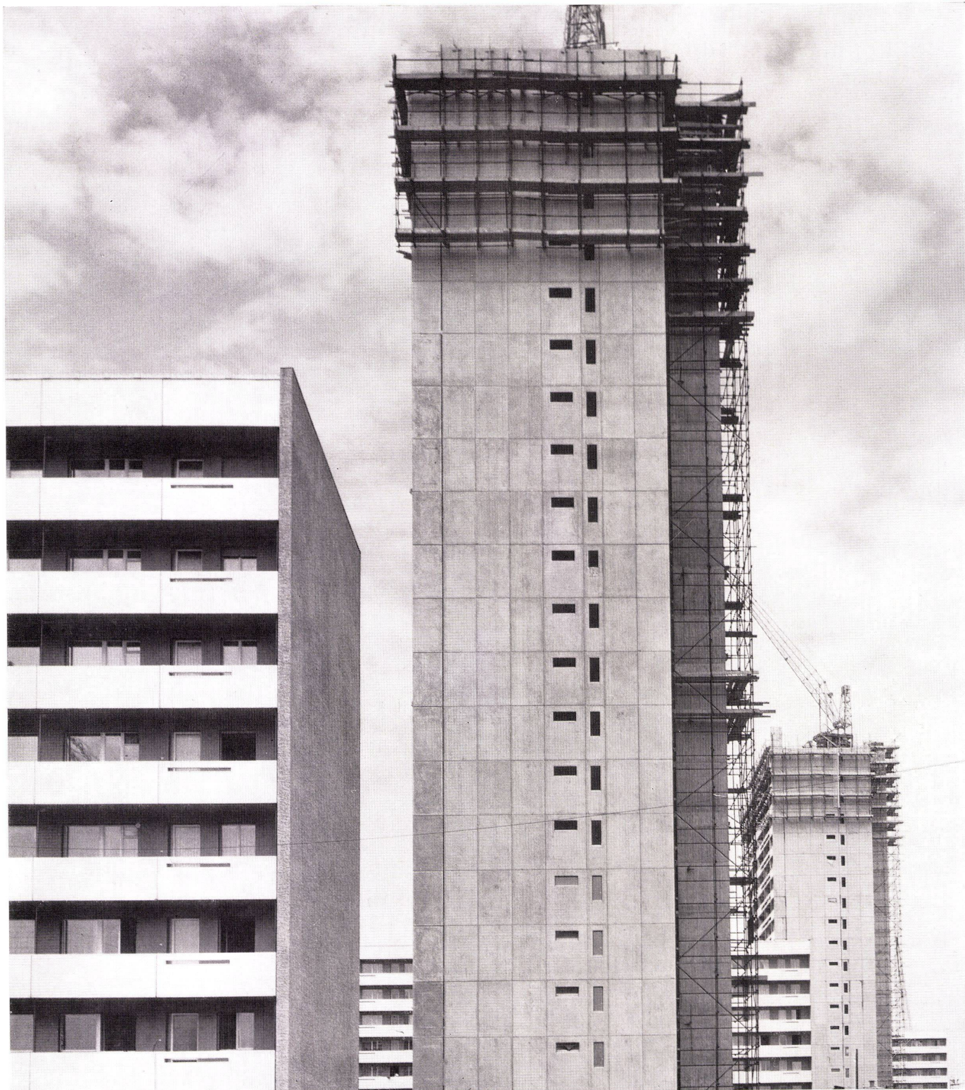
Tragende Sandwichplatten in Stockwerkshöhe; total 20 Geschosse
