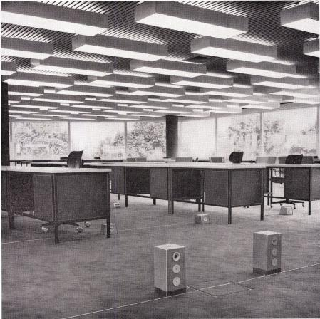
Teli-Flur, das Elektro-Installationssystem in Fußboden und Fensterbankkanal, ist der Träger aller Leitungswege für Starkund Schwachstrom. Der Teli-Flur-Kanal kann auch Jahre nach dem Einbau an jedem
