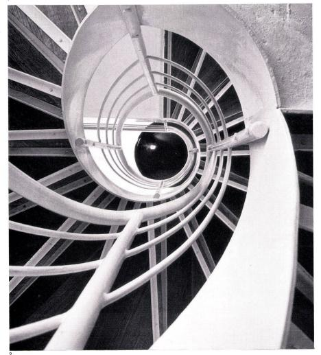
2 Wendeltreppe in Stahl als Geschoßtreppe. Stahlrohr als Geländerpfosten und Handlauf.
