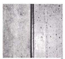
Wenn bei Außenfugen Bedenken gegen die Haltbarkeit der Fugendichtung (s. 4.383) bestehen, so können die Fugen so ausgebildet werden, daß evtl. eindringendes Wasser nach außen abgeleitet wird.
