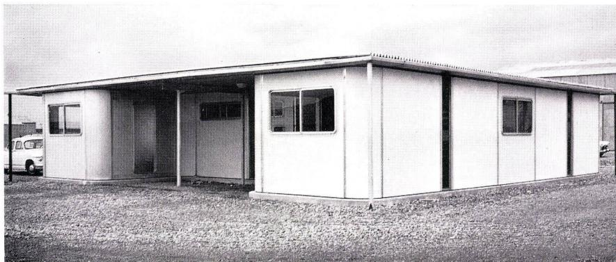
Baustellengebäude in Pierrelatte 1961. Große Elemente, bei denen sich das Holz, das Aluminium und das Glas zu einer Einheit verbinden.
