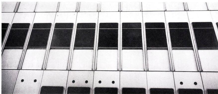
Vorhangsfassade mit selbsttragenden Fassadenelementen.
