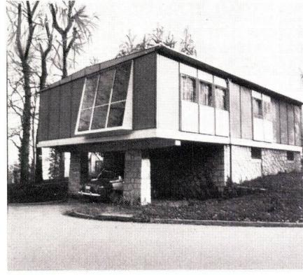
Bau in »Hahn«-Elementen 1948. Diese neue Strukturform gehört zum »Alphabet von Prouvé«. Prouvé entwickelt Strukturen; dadurch unterscheidet er sich von anderen Konstrukteuren.
