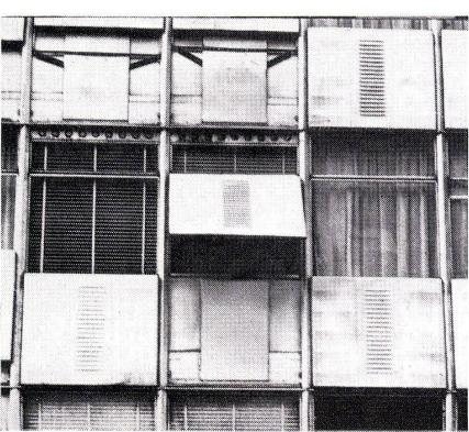
Bürogebäude Square Mozart, Paris 1953. Die Haut dieses Gebäudes besteht aus einer Vorhang-Fassade. Komplette Lösung der Ventilation, von außen montierter Sonnenstoren und mechanischer Betätigung des Fensters. Auch nach 10jähriger Verwendung bleibt dieses Element das schönste der der Mode der Vorhangfassade erfundenen Bauelemente.
