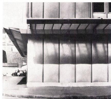
1 Haus BLPS 1938, vollständig in der Fabrik vorgefertigt. Die Details zeigen den neuen Ausdruck, den Prouvé im Metall findet.
