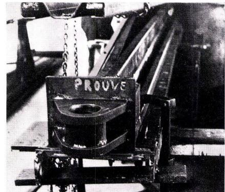
1 Sitz der »Bauföderation« 1949, Paris. Erstes Bürogebäude mit freihängender Fassade; die Elemente sind in der Fabrik vorgefertigt und werden wie ein «Mecano» auf der Baustelle montiert.
