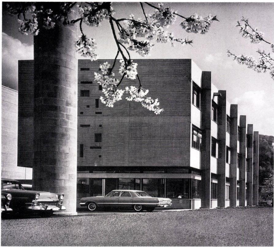
1 Die Decken des Bürogebäudes sind über 13,50 m von Fassade zu Fassade frei gespannt und geben ihre Kräfte über Brüstungsträger an die markanten Stützen ab.
