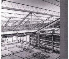
Die Decken des Bürogebäudes sind über 13,50 m von Fassade zu Fassade frei gespannt und geben ihre Kräfte über Brüstungsträger an die markanten
