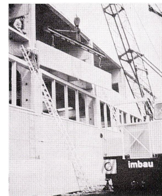
24 Wandtafeln im Hallenbau, zwischen Stützen gespannt.
