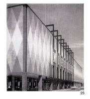
falls mit Fertigteilen gestalteten Fassade eines Warenhauses der Architekten Barancik, Conti & Associates in Chicago. (Bild 25.) Die zahlreichen Möglichkeiten einer Sichtflächenstruktur geben auch neue Gestaltungsformen in die Hand des Architekten.
