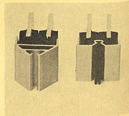
Details der Verglasung. Links starre Verglasung im Plattenrandprofil, rechts Verglasung im Tür-/Fensterflügelprofil.
