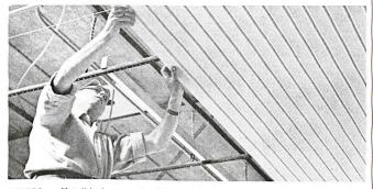
DAMPA Metalldeckenpaneele, demontierbar in Akustik- und Ventilationsdecken
