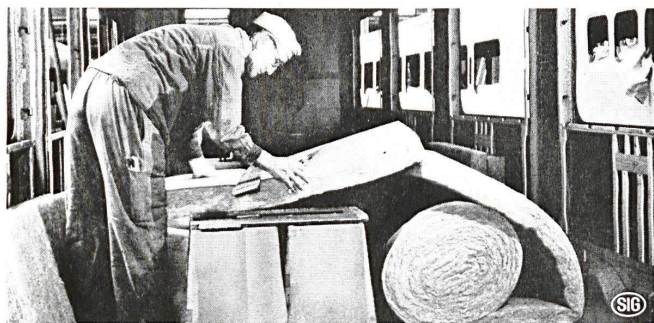
ULTRALITE Isoliermatte, langfaserig, erschütterungsfest und unbrennbar
