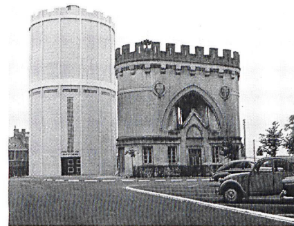
6 Wasserreservoir in Nordfrankreich; es liegen 36 Jahre zwischen der Ausführung der beiden Teile (1925 und 1961); welches ist der alte, welches der neue Teil? Réservoirs d'eau dans le Nord de la France; trente six ans séparent les deux constructions (1925 et 1961); quel est l'ancien, quel est le nouveau? Water reservoirs in Northern France: thirty-six years separate the two structures (1925 and 1961); which is the old one, which the new?
