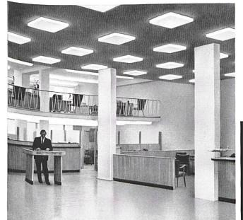
Siemens-Einbau-Deckenleuchten sind für alle gebräuchlichen Zwischendecken geeignet. Ihre Abmessungen entsprechen den üblichen
