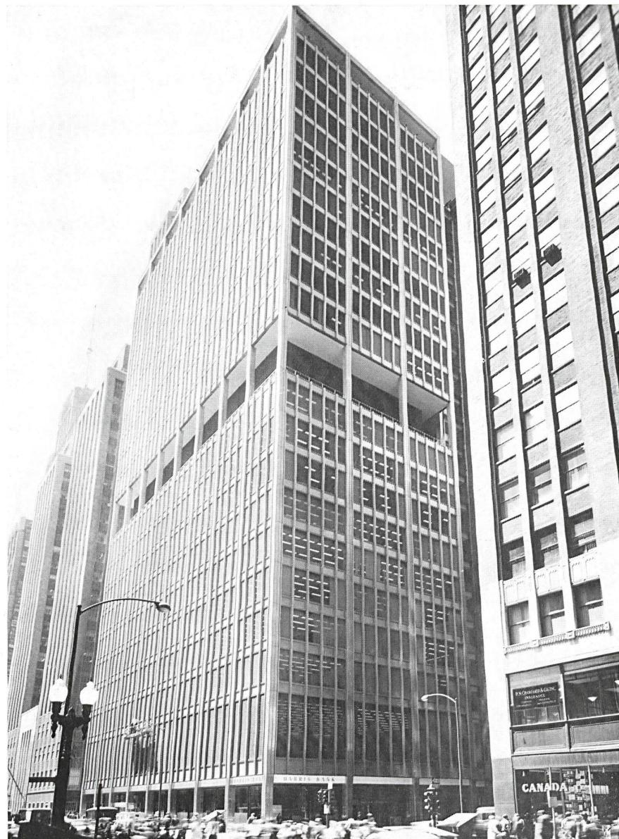
1 Nordostecke an Monroe und Clarke Street. Die zurückgesetzten unteren und obersten Geschosse sowie die beiden Installationsgeschosse bilden waagrechte Zäsuren in der Fassade.
