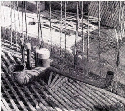
8 Falleleitungen und Sammelleitungen werden in einem Stück, vor dem Betonieren der Decken, versetzt.
