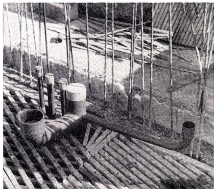
8 Falleitungen und Sammelleitungen werden in einem Stück, vor dem Betonieren der Decken, versetzt.
