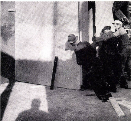
9 Die Verteilungsleitungen werden in die vorgefertigten Wandplatten mit einbetoniert.
