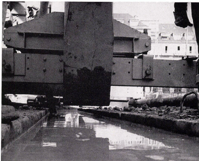
Der mit Bentonit ausgefüllte Schlitz. Überleitung des Bentonitschlammes in den nächsten Grabenabschnitt.
