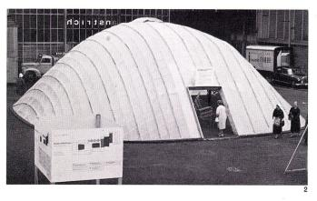
Pneumatische und zugbeanspruchte Kunststoffkonstruktionen werden von Dr. Frei Otto und Rudolf Trostel für die Überspannung von Gebieten mit regulierbarem Eigenklima vorgeschlagen.
