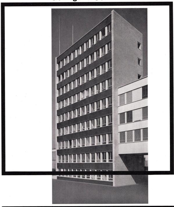
Gebr. Sulzer AG. Werk Oberwinterthur, Laborgebäude. Suter & Suter, Architekten BSA/SIA, Basel. Stahlskelett mit R-Trägerdecken/Durisol-Brüstungsplatten mit äusserer Mosaikverkleidung/BGT-Holzmetallfenster/Sonnenschutz: äussere Rollamellenstoren
