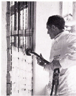
8 Schlitzisolierung – Griso-Spritzschaum wird durch Rippenstreckmetall gedrückt.
