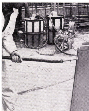
2 Isolation von Metalltüren mit Griso-Spritzschaum.
