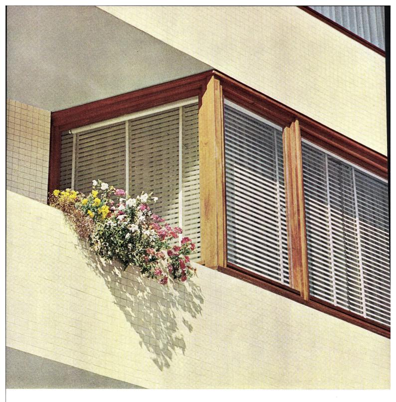
Fassadenverkleidung in Steinzeug-Mittelmosaik. Als Fassadenverkleidungen eignen sich Steinzeug-Bodenplatten und -Mosaike vorzüglich. Sie sind frostsicher, farbenfroh und müssen nicht erneuert werden.
