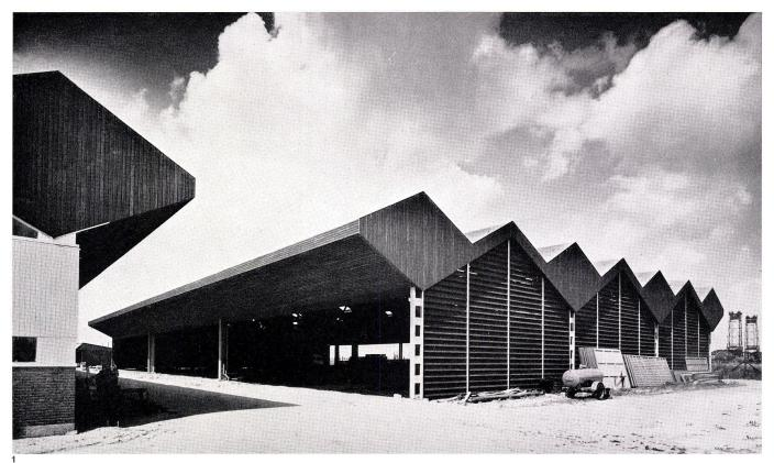
Holzrahmen (Länge 20 m) ihre eingespannte Auflagerung finden. Die Zwischenträger mit einer Spannweite von 11,60 m zwischen den Hauptträgern sind als Dreigelenkbogen gebaut und bilden mit den sattelartigen Erhöhungen das sägeartige Dach.
