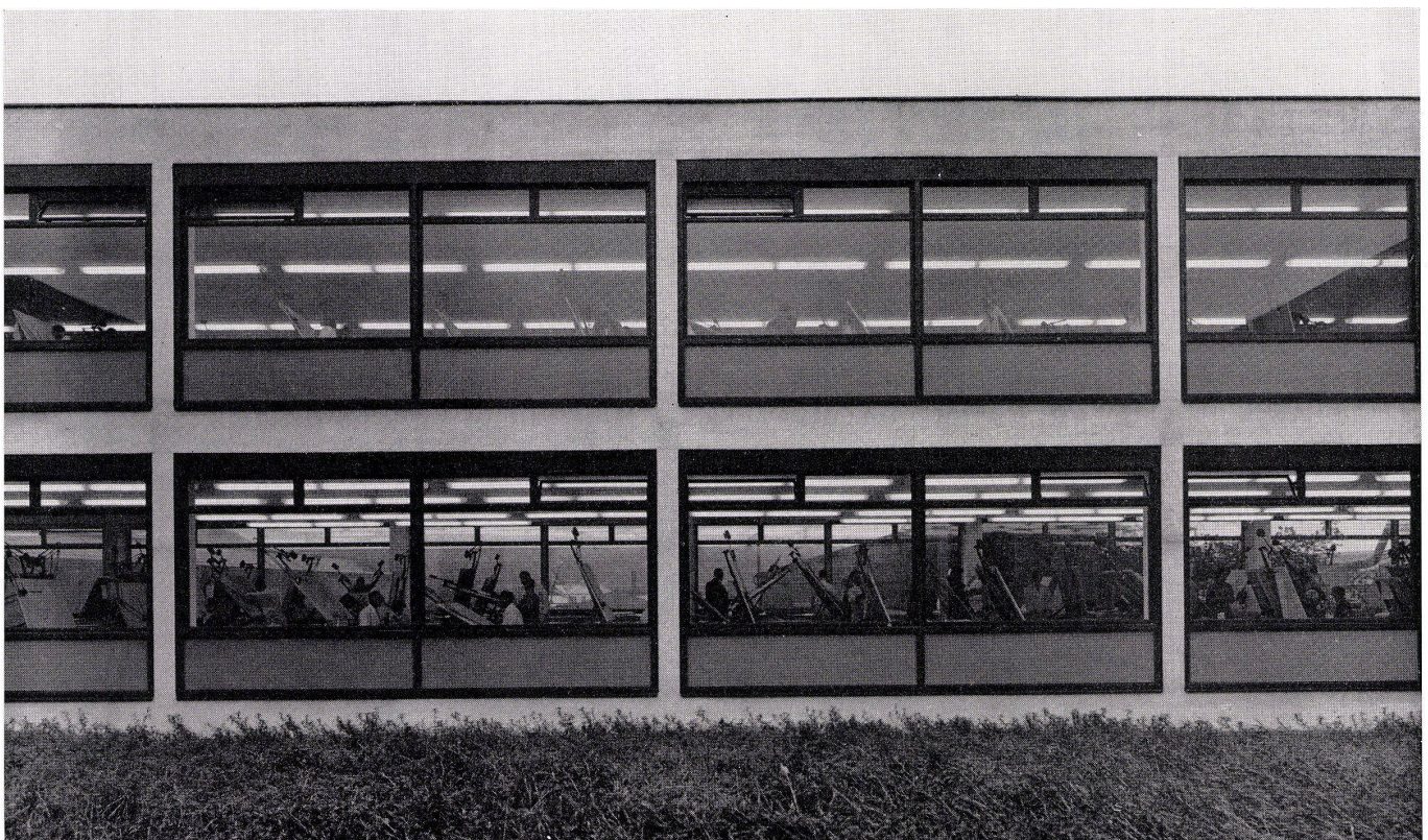
2 Fassadenausschnitt. Sichtbares Stahlbetonskelett, weiß, mit geschoßhohen Fensterelementen. Brüstungen aus Polycolorglas. Partie de façade. Squelette de béton armé apparent, blanc; éléments-fenêtres à hauteur d'étage. Allèges en verre polycolor. Elevation detail. Unfaced reinforced concrete skeleton, white, with storey-high window elements. Polycolor glass parapets.
