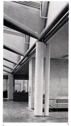
Stützenausbildung der 60 m weit gespannten Stahlkon-struktion im Flachbau. Stahlrohr-Pendelstütze mit dahinter liegendem Regenfallrohr.
