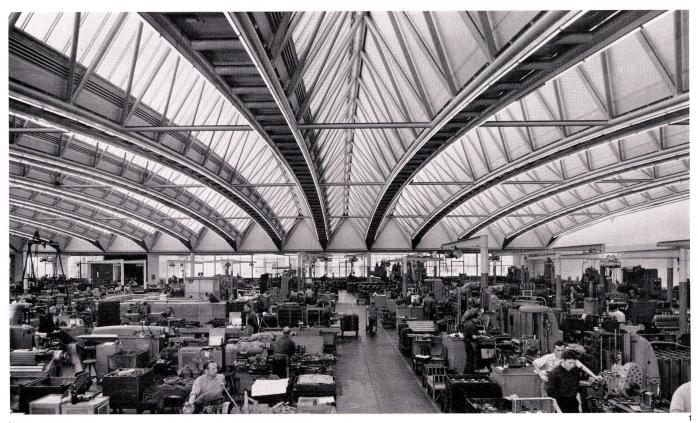
1 Fertigung im stützenfreien Obergeschoß des Flachbaus. Räumliche Stahlrohr-Fachwerkbinder, 60 m frei gespannt. Fabrication à l'étage supérieur du bâtiment plat sans piliers. Construction en triangle de tubulaire 60 m portée.
