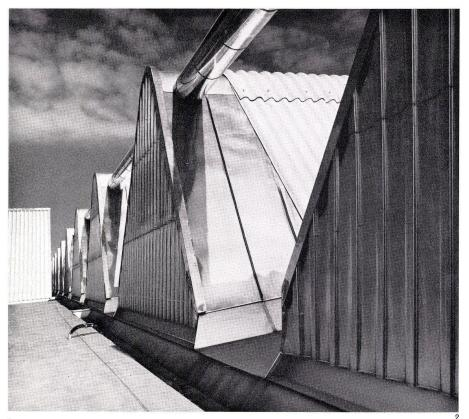
Giebelausbildung der räumlichen Stahlfachwerkbinder. Obergurt der Längsträger mit Wärmedämmung und Aluminiumverkleidung.
