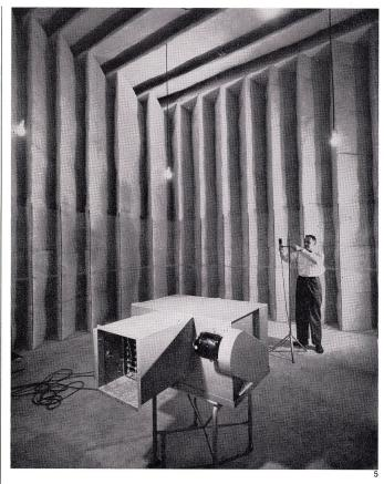
Geräuschmeßraum bei Carrier & Co., Syracuse / Werkaufnahme bei Carrier & Co.
