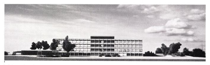
Im Schwerpunkt der Gebäude liegt in strenger Zusammenfassung der Block für die Aufnahme der vertikalen Verbindungen und der sanitären Einrichtungen.
