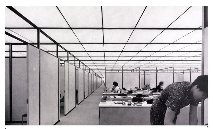
1 Blick in den Kern eines Bürogeschosses. Das Rastermodul von 5 Fuß (1,5 m) kennzeichnet den ganzen Bau. Die Metallschienen der Decke dienen als Fixpunkt der Trennwände und als Austrittsöffnungen für die klimatisierte Luft. Die Decken des ganzen Gebäudes sind als Lichtdecken ausgebildet. Über dem undurchsichtigen Teil der Zwischenwände ist durch das ganze Gebäude durchgehend ein Glasband angeordnet, das die Großräumigkeit der Geschosse hervorhebt.
