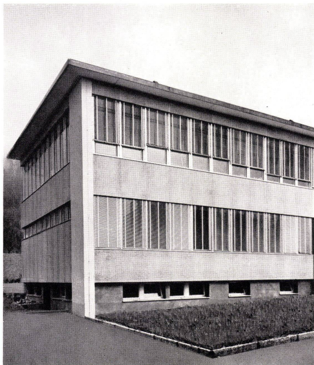
Am Neubau dieser Uhrenfabrik in Grenchen wurden die Vorhangbauelemente an der Trägerkonstruktion direkt mit GOMASTIT befestigt und verfugt.
