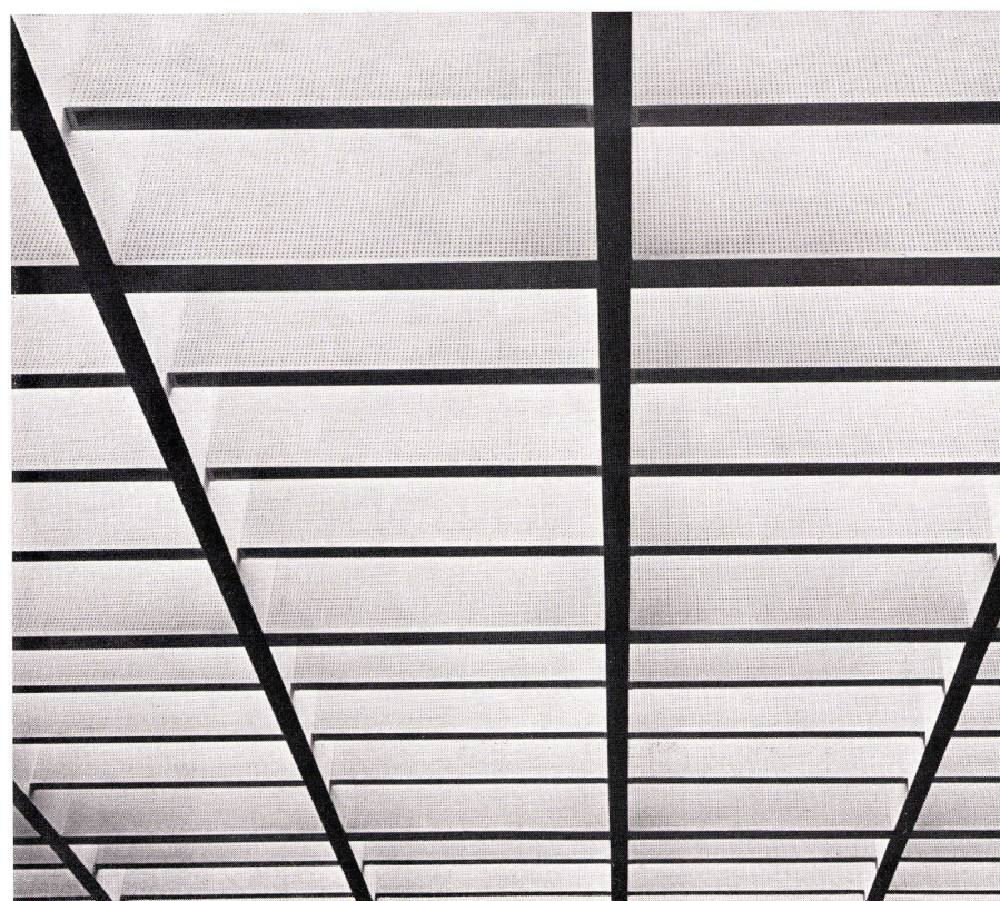
2 Akustikrost unter dem Shedoberlicht (siehe Konstruktionsblatt). Plafond vu de dessous. Ceiling seen from below.
