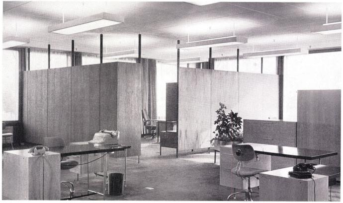
oberhalb des vorhin erwähnten Akustikrasters ist eine weitere Glasdecke aus lichtstreuendem Glas eingebaut. Es ergeben sich theoretisch ermittelte Werte, bezogen auf mittags 12 Uhr, von 750 Lux im Juni und 580 Lux im Dezember auf den Schreibtischebenen unter dem Oberlicht bei bedecktem Himmel.
