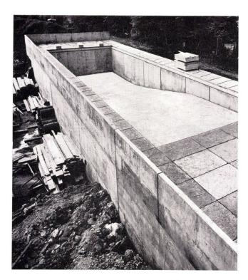
Im Schwimmbassin der Siedlung Halen bei Bern wurden die Fugen mit GO-MASTIT abgedichtet. Unser Bild zeigt die im Bau befindliche Badeanlage.
