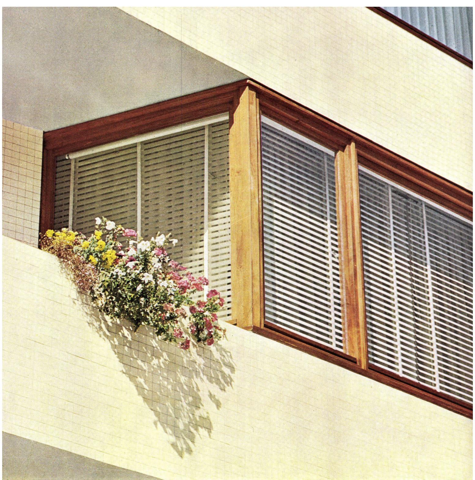
Fassadenverkleidung in Steinzeug-Mittelmosaik. Als Fassadenverkleidungen eignen sich Steinzeug-Bodenplatten und -Mosaiken vorzüglich. Sie sind frostsicher, farbenfroh und müssen nicht erneuert werden.
