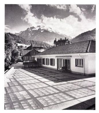
Auf diesem Flachdach eines Restaurants im Berner Oberland wurden die Fugen mit GOMASTIT ausgegossen und damit absolut wasserdicht gemacht.
