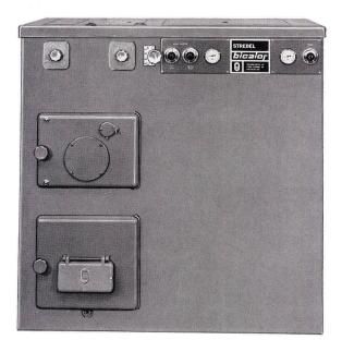
STREBEL- ist speziell für Ölfeuerungen eingerichtet, läßt sich jedoch mit wenigen Handgriffen auf Koksfeuerung umstellen.
