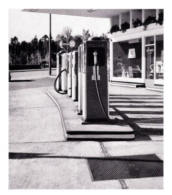
Auf dem betonierten Vorplatz dieser Tankstelle wurden die Bodenfugen durch uns nachträglich mit GOMASTIT verkittet und damit öl- und benzindicht gemacht. Die zuerst verwendete Bitumenmasse hatte dem Auto-Öl und Benzin nicht widerstanden.
