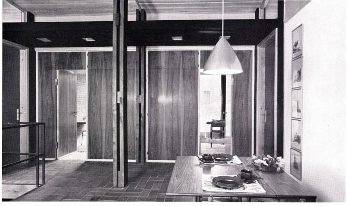
1 Anschlüsse von Backsteinmauer, Türe und abgehäng-tem Lattenrost an Eichenstütze. Raccords entre le mur de brique, la porte et le grillage de bois du pilier de chêne.
