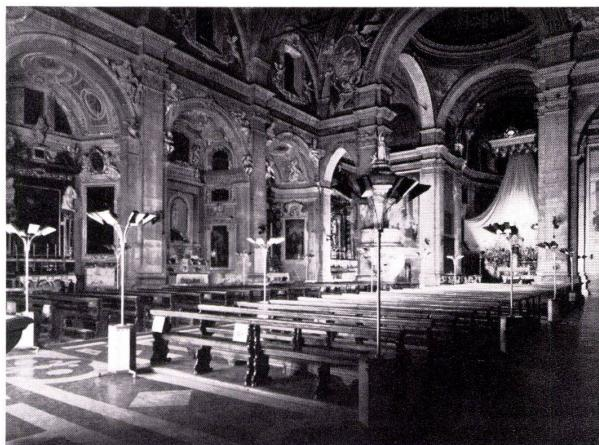
Propan Infrarot-Heizung. Collegiata Bellinzona. 800 m<sup>2</sup> Grundfläche. Heizkosten Saison 1959/60 unter Fr. 1000.-. Baudenkmal, daher bewegliche Geräte ohne jegliche Installationskosten. Gasflaschen sind in den Geräten eingebaut.
