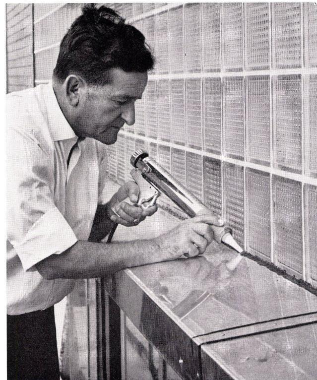
Am Neubau der Zuckerfabrik Aarberg wurden sämtliche Blechverkleidungen der Simse sowie die vorgehängten Bauelemente durch uns mit der Thiokol-Kittmasse GOMASTIT abgedichtet.
