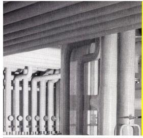
Heizungsronre mussen Sicherheit bieten. Erst wenn diese Forderung erfüllt ist, darf der Preis eine Rolle spielen. Bei ARFA-Siederohren ist jedes einzelne Rohr mit 100 atü Kaltwasser auf Dichtigkeit geprüft. Deshalb bieten sie in hohem Masse Sicherheit – aber dank rationeller, neuzeitlicher Produktion sind sie auch noch wirtschaftlicher.
