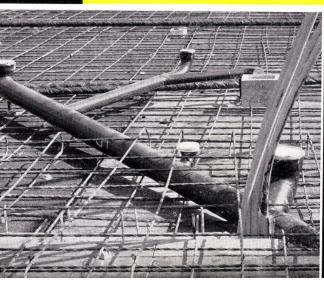
ARFA-Stahlablaufrohre sind praktisch und helfen die Baukosten senken. Sie beanspruchen viel weniger Raum. Damit werden die Deckenstärken geringer, die Mauerschlitze enger, die Nutzfläche grösser. Sie erfordern weniger Stemmstellen als Formstückleitungen. Dies senkt die Montagezeit und ermöglicht das Einlegen in Beton. Sie bieten auch Sicherheit, denn sie sind mit einem Speziallack ausgezeichnet gegen Korrosion geschützt.
