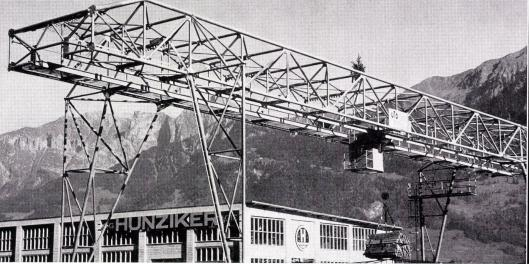
Kranbrücken aus ARFA-Stahlrohren sind leichter als Profilkonstruktionen. Damit lassen sich aber nicht nur Einsparungen bei der Kranbrücke erzielen. Auch die Kranbahn, die Stützen, die Fundamente und der Antrieb können wirtschaftlicher dimensioniert werden.
