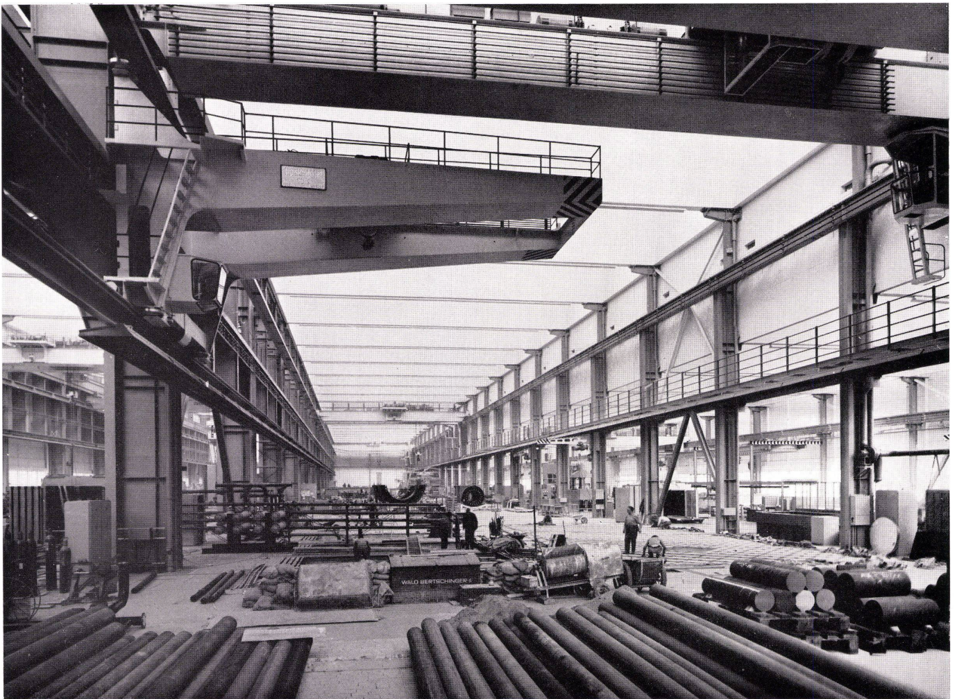
Neubau AG Brown, Boveri & Cie. im Birrfeld Architekt: Dr. R. Rohn, Zürich
