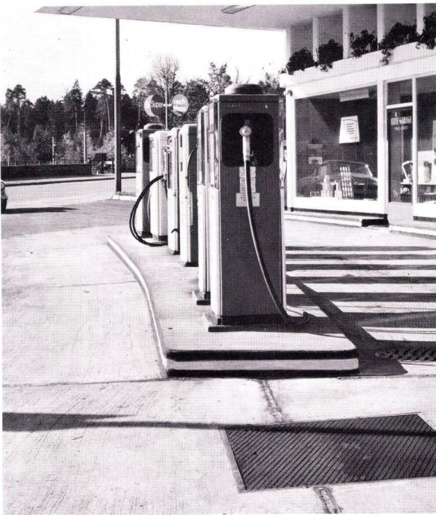
Auf dem betonierten Vorplatz dieser Tankstelle wurden die Bodenfugen durch uns nachträglich mit GOMASTIT verkittet und damit öl- und benzindicht gemacht. Die zuerst verwendete Bitumenmasse hatte dem Auto-Öl und Benzin nicht widerstanden.
