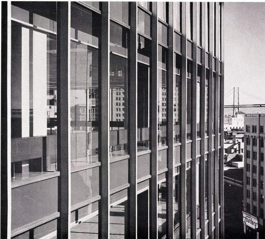
3 Ausschnitt einer Fassade. Das Profil der stehenden Aluminiumsprossen ist außerordentlich schlank. Partie de façade. Les profils verticaux des fenêtres en aluminium sont extrêmement minces. Detail of an elevation. The profile of the vertical aluminium rundles is extraordinarily slender.
