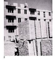
Ein tschechisches Beispiel einer Baustelle mit vorfabrizierten Bauelementen. Die beiden Untergeschosse dienen während der Bauausführung als Fabrikationsraum für die Herstellung der Bauelemente.
