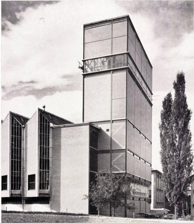
**Am Neubau der Zuckerfabrik Aarberg** wurden sämtliche Blechverkleidungen der Simse sowie die vorgehängten Bauelemente durch uns mit der Thiokol-Kittmasse **GOMASTIT** abgedichtet
