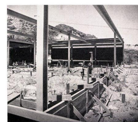
1 Das Stahlgerüst ist über den Einzelfundamenten aufgerichtet. Auf Dachhöhe und über den Fundamenten sind U-Eisen als Rahmen an die Stahlbinder geschweißt.
