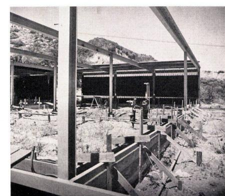
1 Das Stahlgerüst ist über den Einzelfundamenten aufgerichtet. Auf Dachhöhe und über den Fundamenten sind U-Eisen als Rahmen an die Stahlbinder geschweißt.
